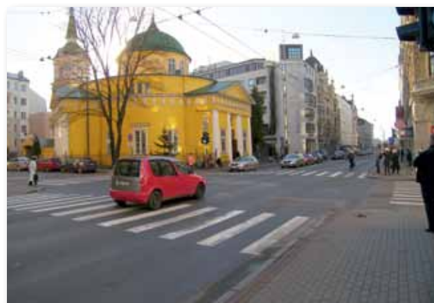
2010. gadā daudzviet uzstādīti luksofori uz gaismas emisijas diožu bāzes.
